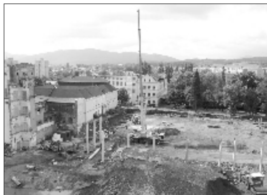
Práce na základech areálu supermarketu Hypernova jsou v plném proudu, aby se termín jeho dokončení, tj. konec letošního roku, podařilo splnit. Pro návštěvníky velkoobchodu zde bude k dispozici 155 parkovacích míst, hlavní vjezd bude z ulice Národní, průjezd však bude umožněn i z ulice Legií kolem parkoviště prodejny Billa. Foto rm/rd
