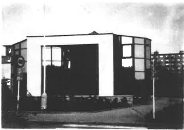
Skleněná fasáda - jedna z možností, které nabízí montáže izolačních dvojskel do hliníkových profilů.
