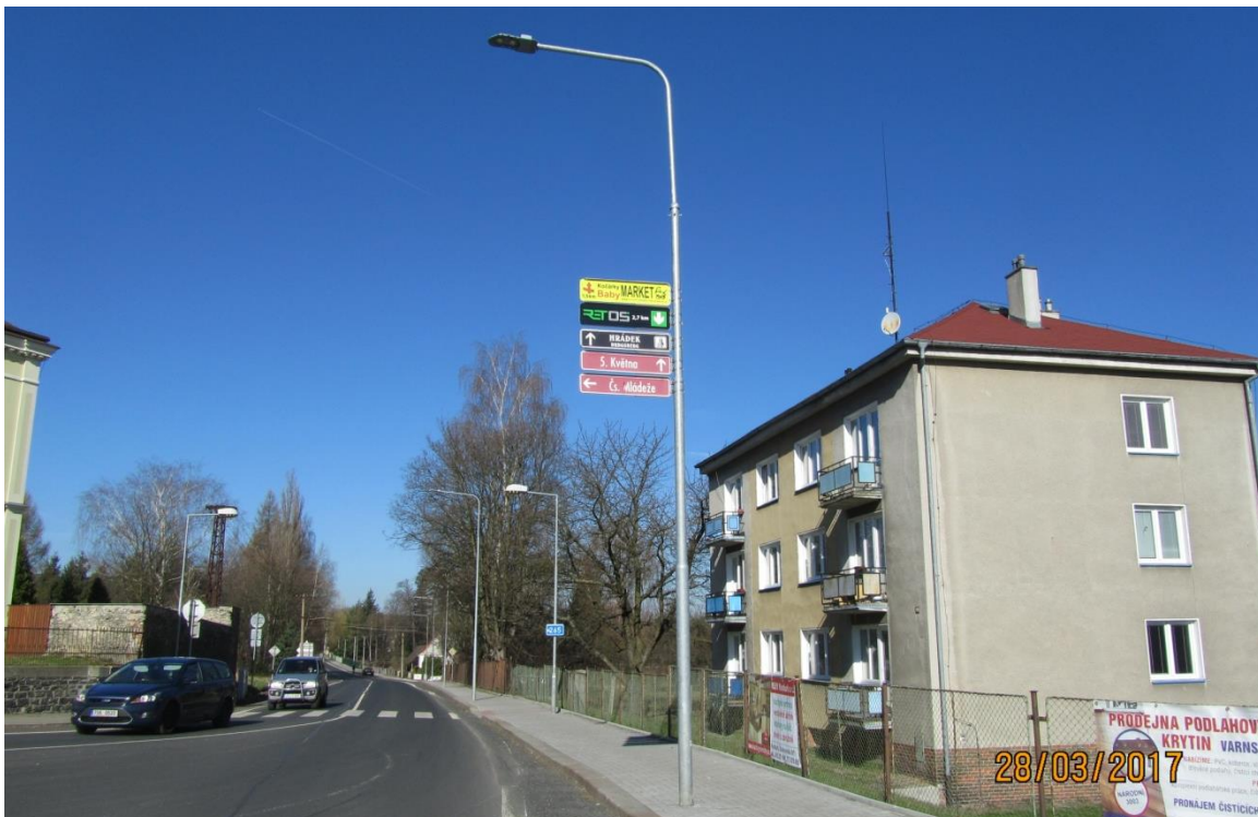
Ulice 5. května – nový chodník a veřejné osvětlení
