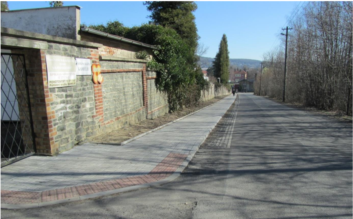
Ulice Hřbitovní - nový chodník
