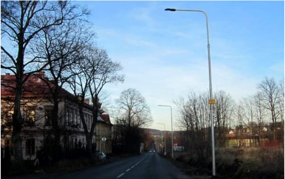
Nové osvětlení na ulici Plzeňská
