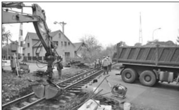
Rekonstrukce přejezdu. V polovině října jsme zastihli dělníky při rekonstrukci železničního přejezdu u restaurace Severka.
