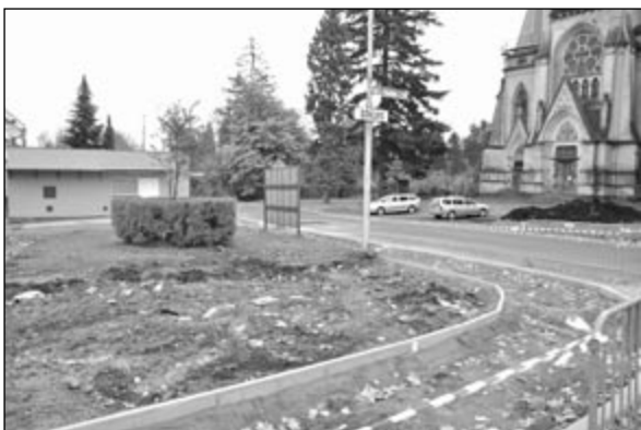
Výstavba nového chodníku na křižovatce Karlovy a Kostelní ulice
