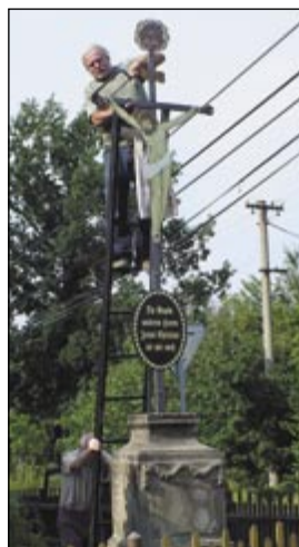
Miroslav Hejný dokončuje instalaci plechových součástí křížku.
