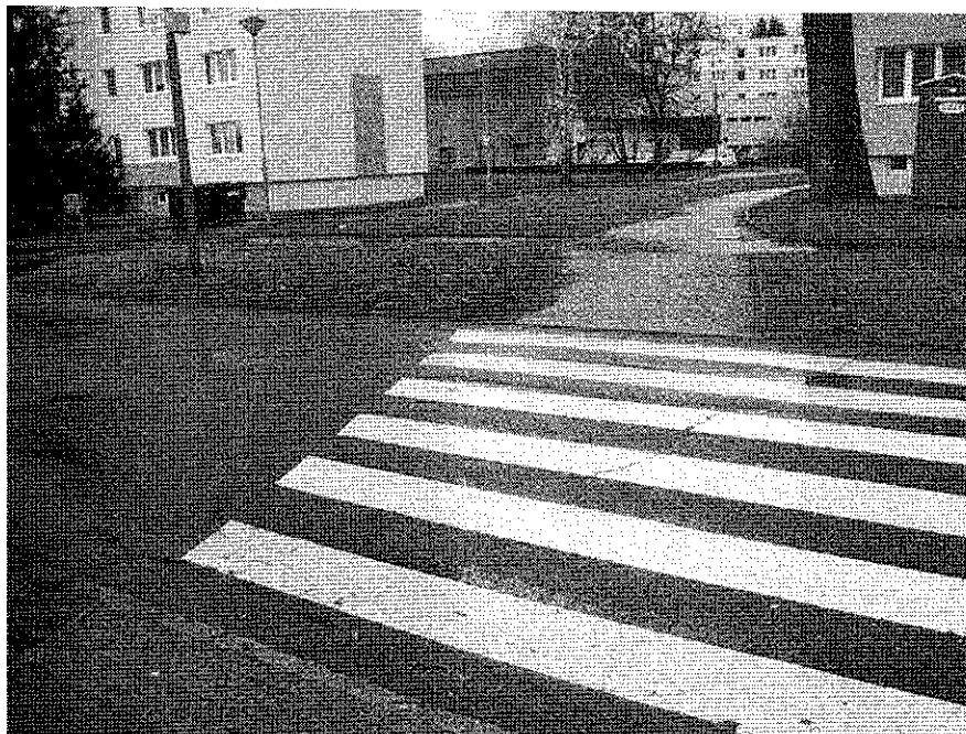
současný přechod ze sídliště směr park
