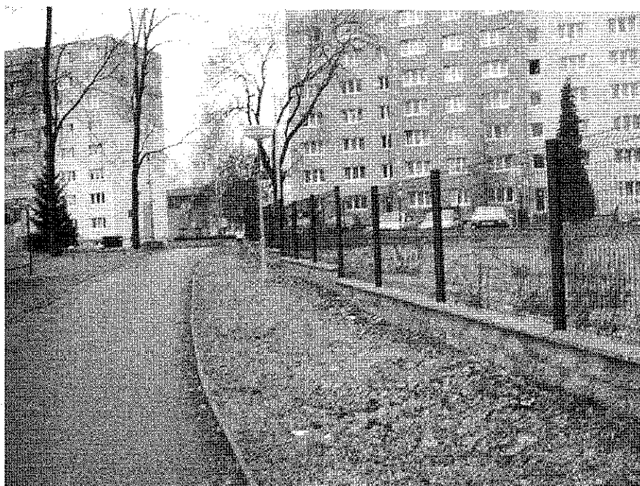
severní část s přílehlou plochou bazénu
